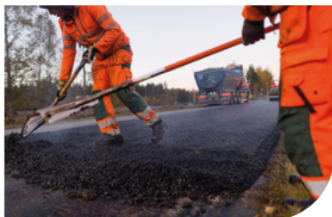
Matériaux de construction et asphalte
